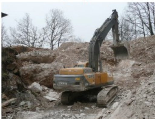
Photographie 7 : Décapage à la pelle hydraulique
