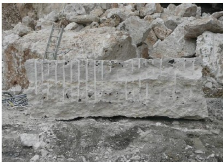
Photographie 9 : Perforations pour décollement par mortier expansif non explosif
