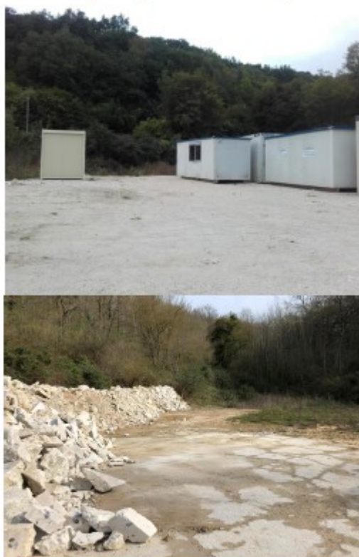
Photographie 2 : Carreau nettoyé, dalle béton, stockage d'algéco et chutes de pierres
